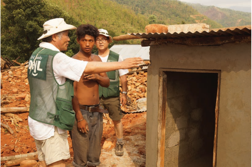
마을 공동화장실 건축 현장
